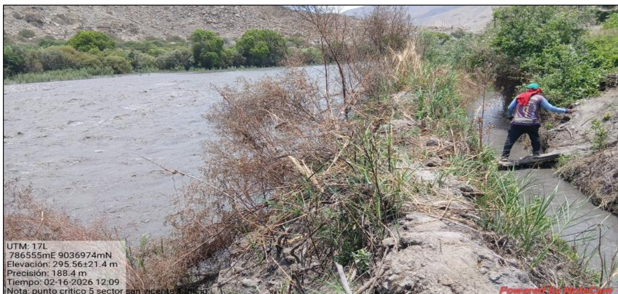
FIGURA N°02: EN LA IMAGEN SE APRECIA EL TRAMO CRITICO SAN VICENTE 1, CUYO TRAMO SE ENCUENTRA EN RIESGO POR EL COLAPSO DEL CANAL CD SUCHIMAN Y VULNERABLE A LAS VELOCIDADES EROSIVAS DEL RIO.
